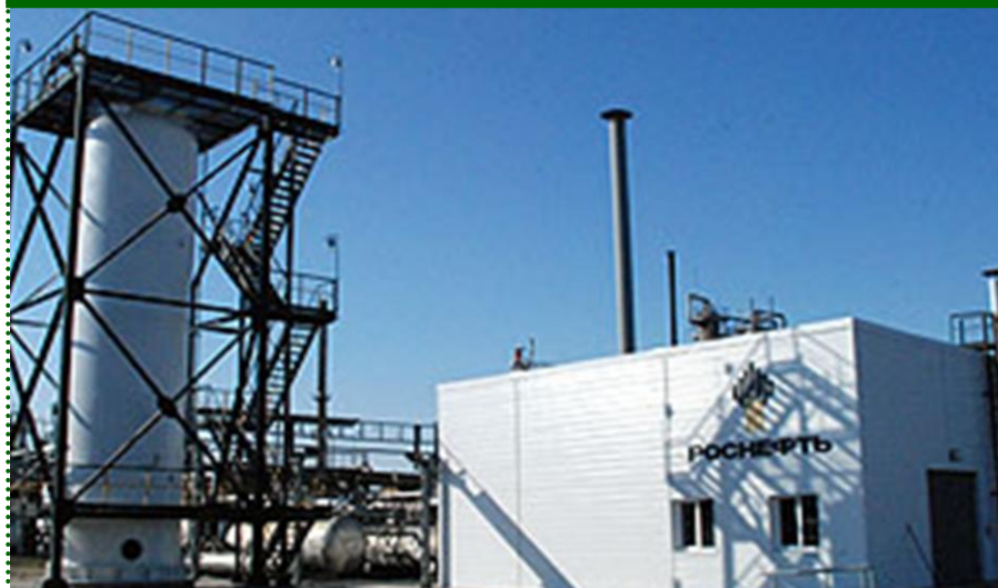
Рис. 18. Узел ввода присадок для топлива на Сызранском НПЗ
