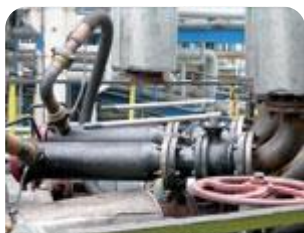
Рис. 2. Узел подключения установки к секции печи (печи)
